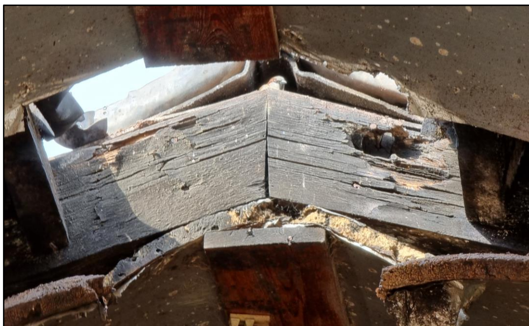
Figuur 1.3 Een van de open delen in de zuidelijke schuur waar huismussen nestgelegenheid kunnen vinden tussen het isolatiemateriaal en de golfplaten.
