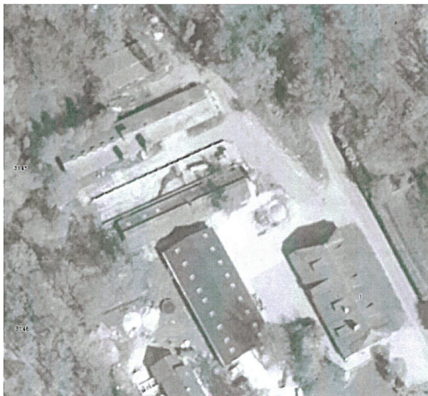
1998. Schuur ten westen van hoofdgebouw is vernieuwd.
