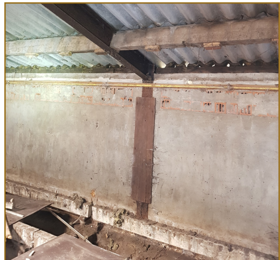
Afb. 2.4: Binnenkant van een schuur.
