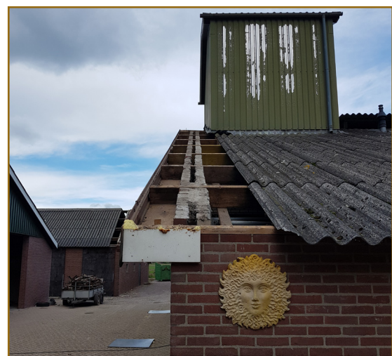
Afb. 2.6: Open spouw omdat de dakplaten ontbreken. Dit is bij alle schuren het geval. Door lichtinval en tocht is de spouw dus niet geschikt voor vleermuizen.
