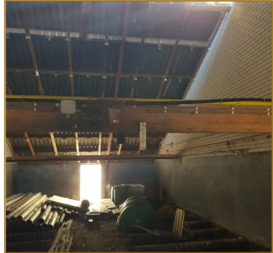
Afb. 2.2: Binnenkant van een schuur. Alle schuren hebben dezelfde bouw.
