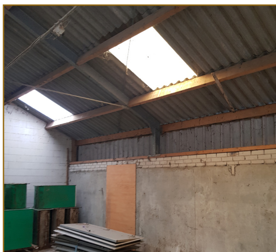
Afb. 2.5: Binnenkant van schuur 7.
