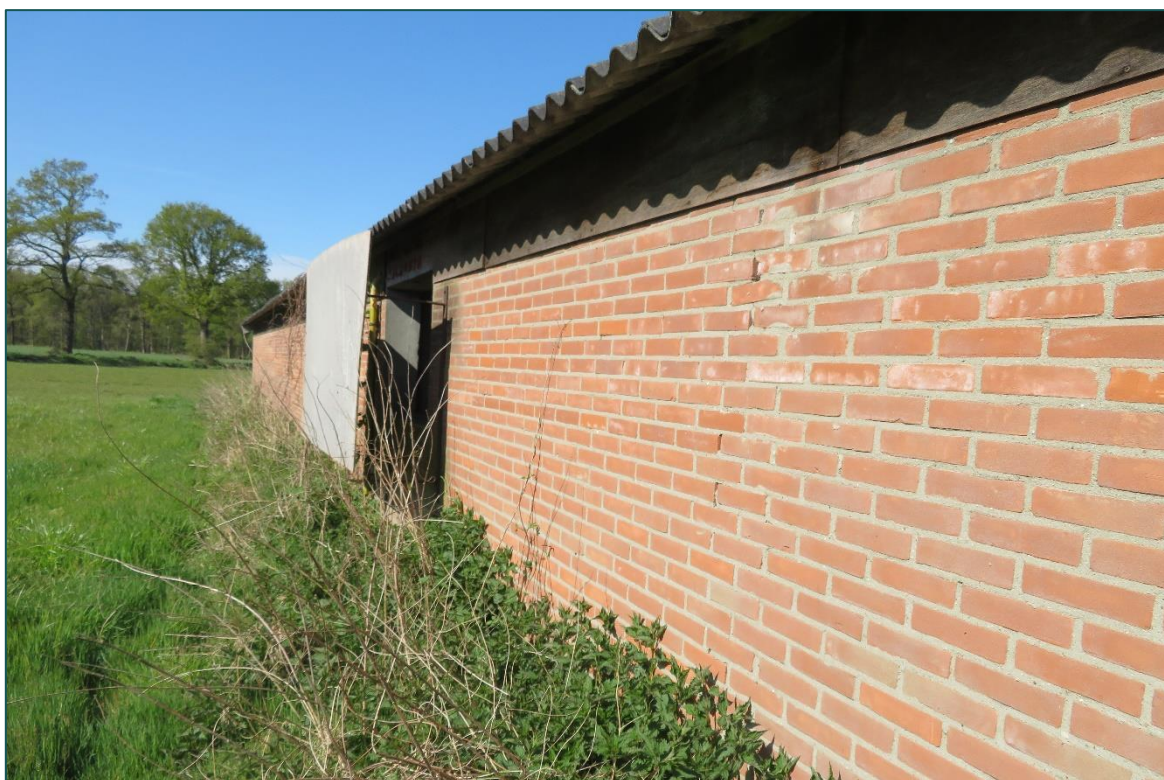
Figuur 2 De bebouwing bestaat uit gemetselde muren met een golfplaten dak.
