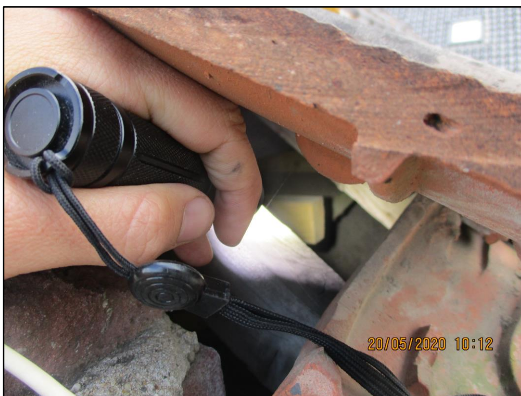
Figuur 4 Grote open ruimte onder de dakpannen van de schuur op de planlocatie. Door deze grote open ruimte is er geen potentie voor een verblijfplaats van vleermuizen of nestlocaties van huismussen.
