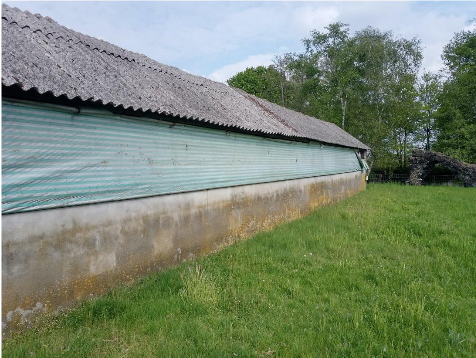
Foto5; metselwerk zonder spouw
