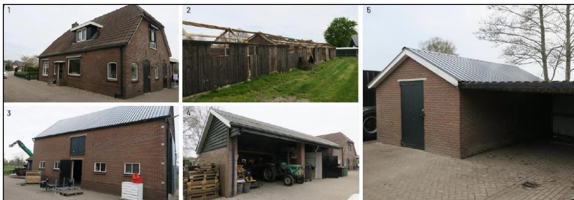
Figuur 1.2 De te slopen bebouwing betreffen vier schuren.
