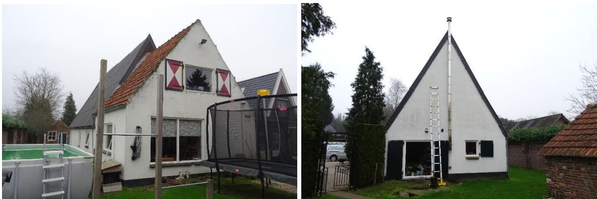
Afbeelding 3 en 4: De te slopen woning. Bron: BNL advies. Datum: 26-01-2022
