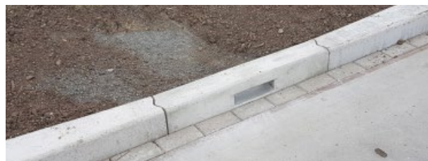
Hemelwater loopt via speciale voorzieningen naar de waterbergingen
