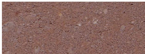
De rijbaan wordt uitgevoerd in een bruin/rode Geocolor BSS dikformaat (keperverband)
