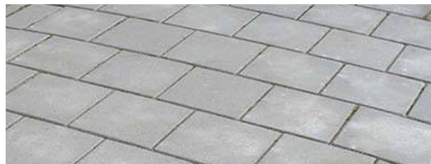
De trottoirs zijn voorzien van een grijze 30 x 30 cm betontegel met facet (halfsteensverband)
