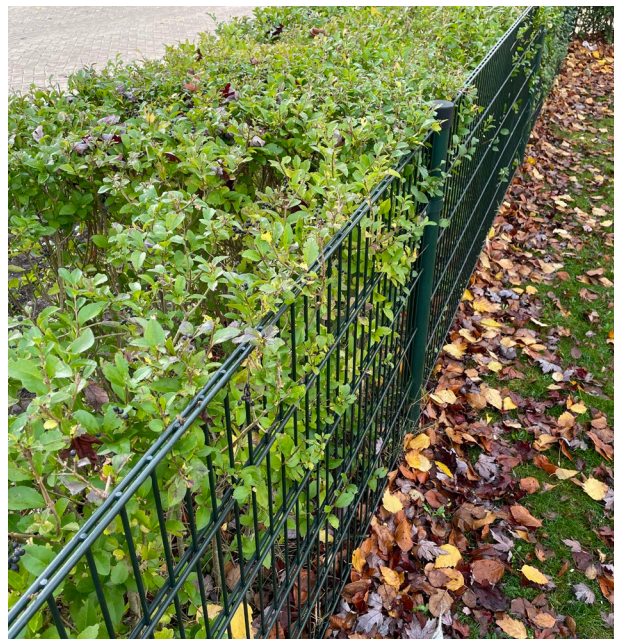
Rondom het speelveldje wordt een veldesdoornhaag aangeplant. Aan de binnenzijde komt een hekwerk van dubbelstaafsmatten (kleur: antraciet).
