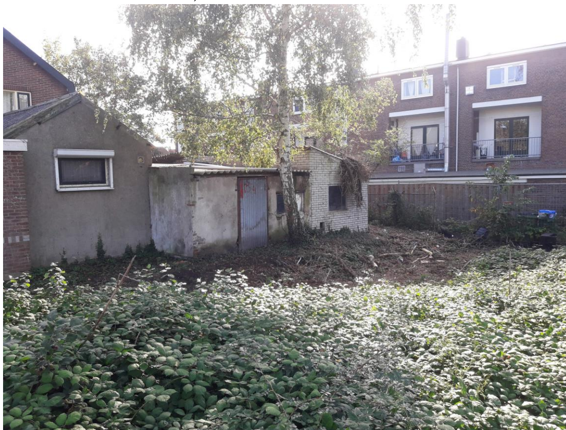
Schuur met asbestverdacht dak, zuidwesthoek onderzoekslocatie
