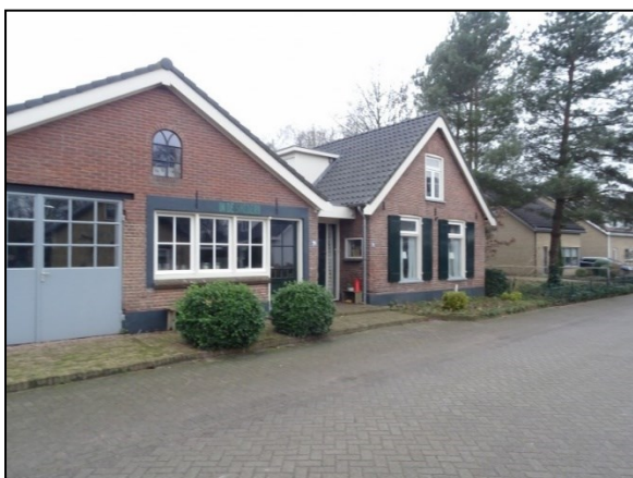
Mogelijkheden overstek aan te passen voor gaten in de onderzijde aan te brengen (punten als inbouwvoorziening laatvlieger)
