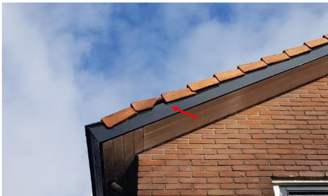
Figuur 2.4: Opening in dakpan die geschikt is voor gierzwaluw en huismus (foto's: Laneco, maart 2020).
