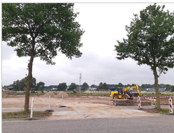
afb. 2. links boom 549 en rechts boom 550, waartussen de tijdelijke inrit wordt aangelegd
