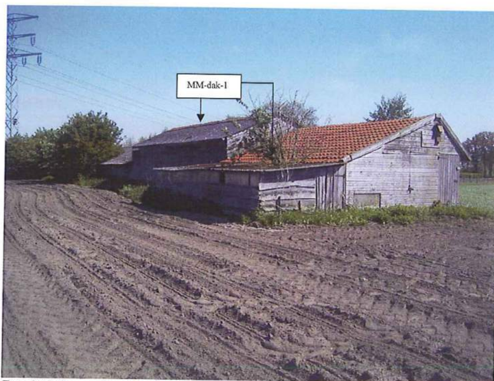
Foto 3: Geïntervieweerde schuur met grootste deel van de dakbedekking asbesthoudende golfplaten vanuit noordwestelijke richting gezien.
