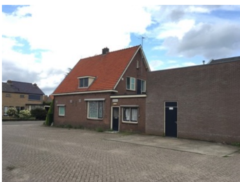
Figuur 7. Noordwesthoek bedrijfsterrein.
