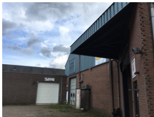
Figuur 6. Noordwesthoek bedrijfshal.
