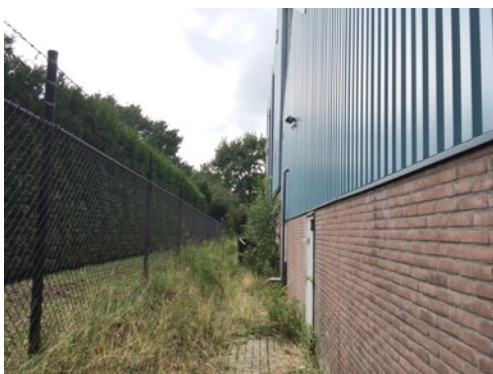
Figuur 5. Achterzijde bedrijfsterrein.
