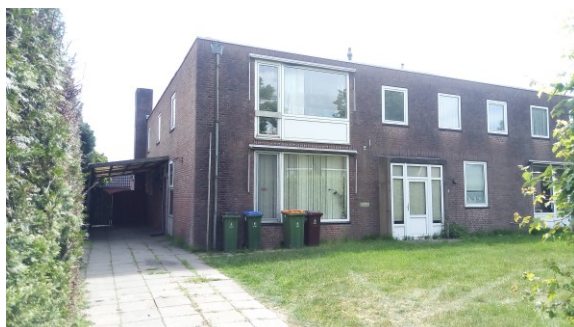
Foto 3: Toegangspad op noordwestelijk deel van de locatie, gefotografeerd in oostelijke richting.
