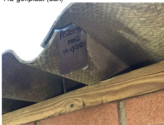
AC golfplaat (dak)
