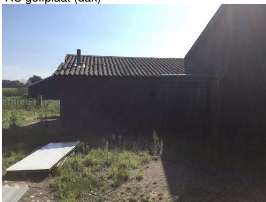
AC golfplaat (dak)
