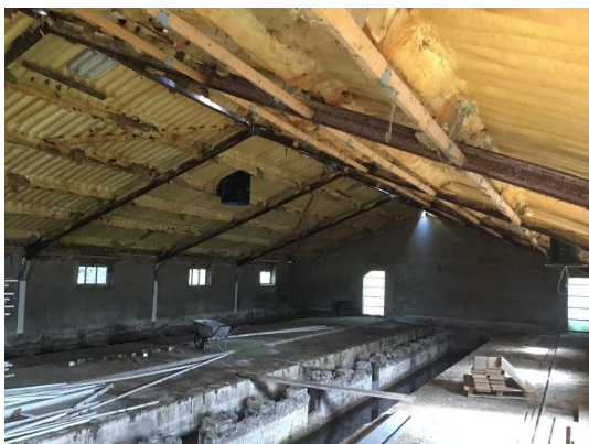
AC golfplaat (dak)
