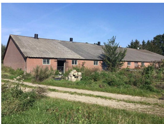
AC golfplaat (dak)
