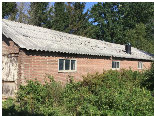
AC golfplaat (dak)
