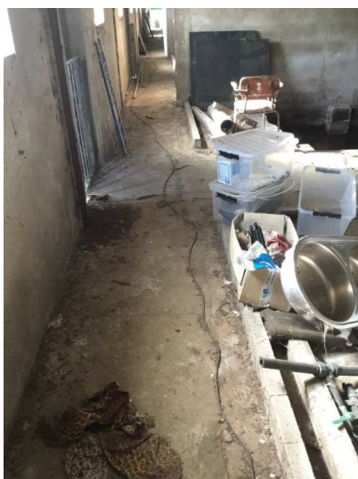
AC golfplaten (verloren bekisting)
