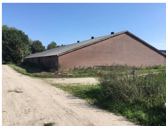
AC golfplaat (dak)
