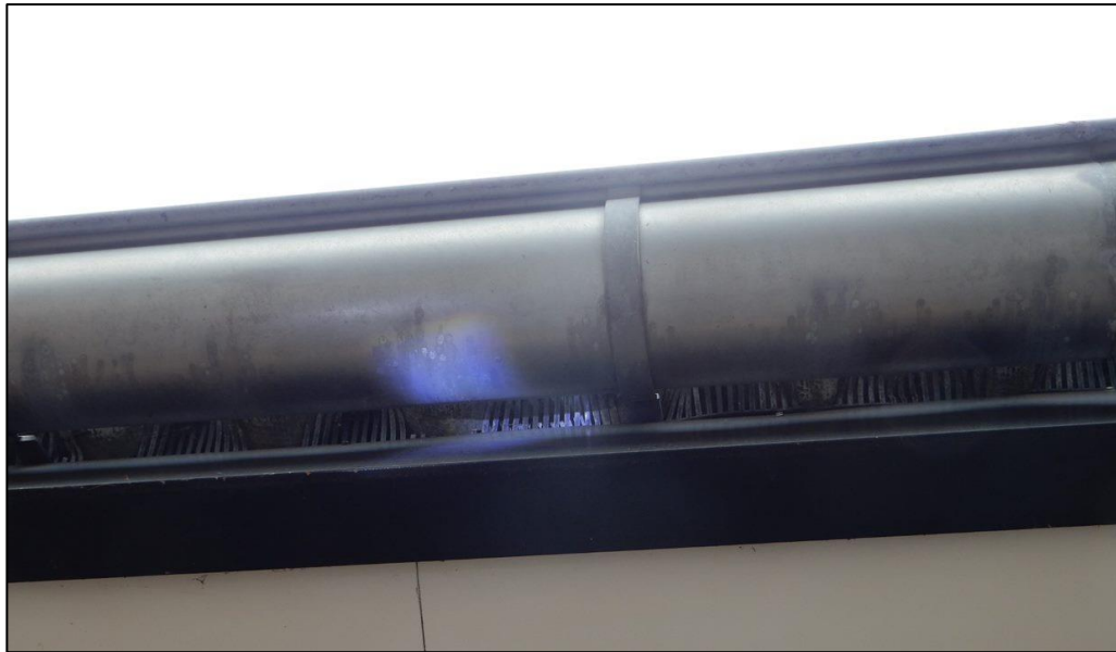
Figuur 3 Fotografische indruk van de aanwezigheid van vogelwerend materiaal onder het golfplaten dak van schuur 2.
