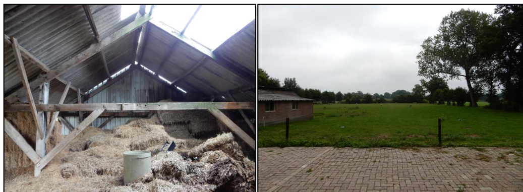
Figuur 1.3 Schuur A, de planlocatie en de directe omgeving hiervan hebben mogelijk een functie voor de kerkuil en/of steenuil.
