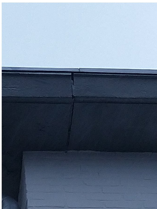
Spleet in dakoverstek in het bijgebouw. Foto: C. E. Bakker | Ecoresult B.V.
