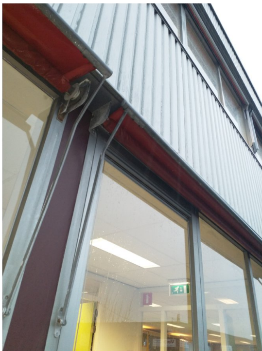
Zonnewering op de gevels. Foto: C. E. Bakker / Ecoresult B.V.
