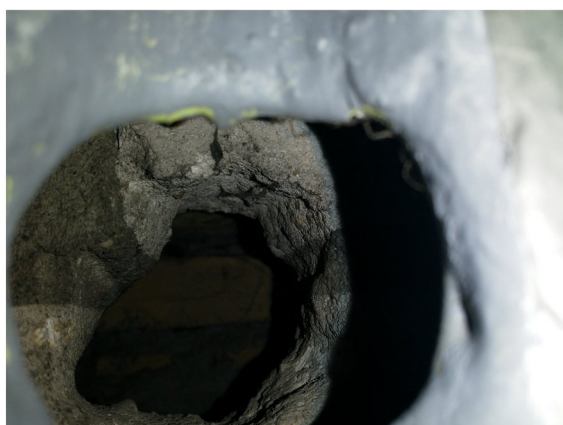
Gat in de oostgevel van het hoofdgebouw. Spouwmuur constructie is te zien. Foto: C. E. Bakker | Ecoresult B.V.
