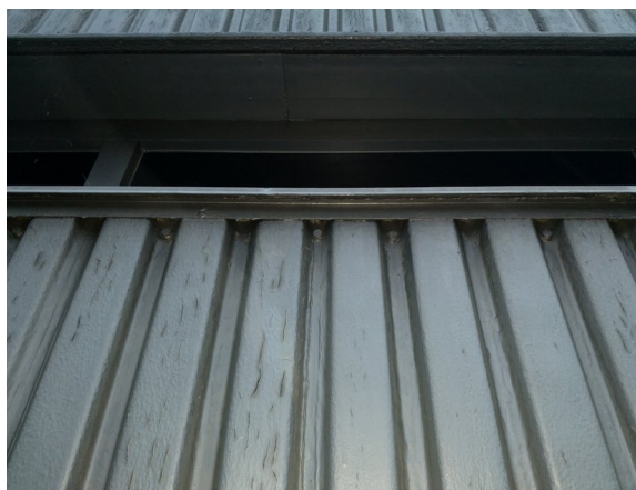
Detail 1 van golfplaten tegen de gevels. Foto: C. E. Bakker / Ecoresult B.V.
