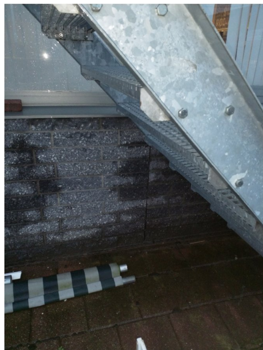
Stenen opbouw eerste meter van de gevel. Foto: C. E. Bakker | Ecoresult B.V.
