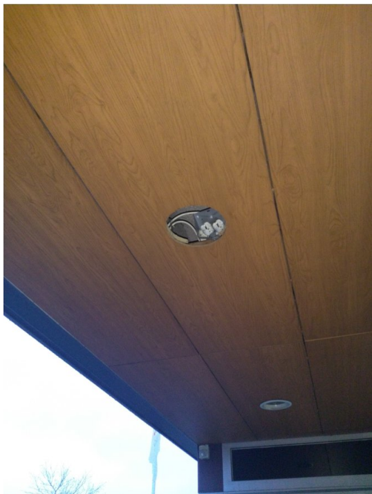
Open gat bij missende lamp. Foto: C. E. Bakker | Ecoresult B.V.
