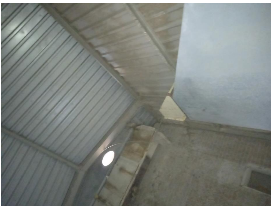
Dak van de afstort! Door het gat kunnen vogels in- en uitvliegen. Het stalen profieldak, zonder isolatie biedt geen onderkomen voor dieren en zou 's-zomers ook te heet worden..
