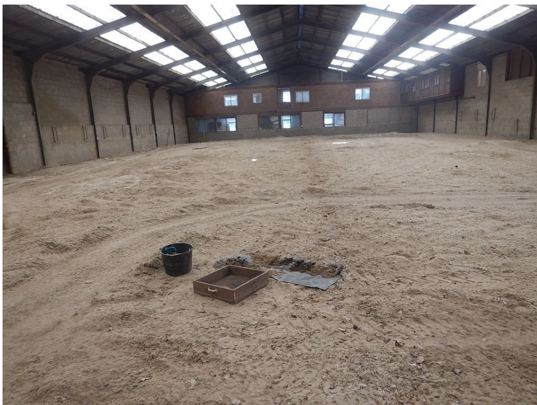
Figuur 8: Foto genomen tijdens veldwerk ter hoogte van boorpunt 16.
