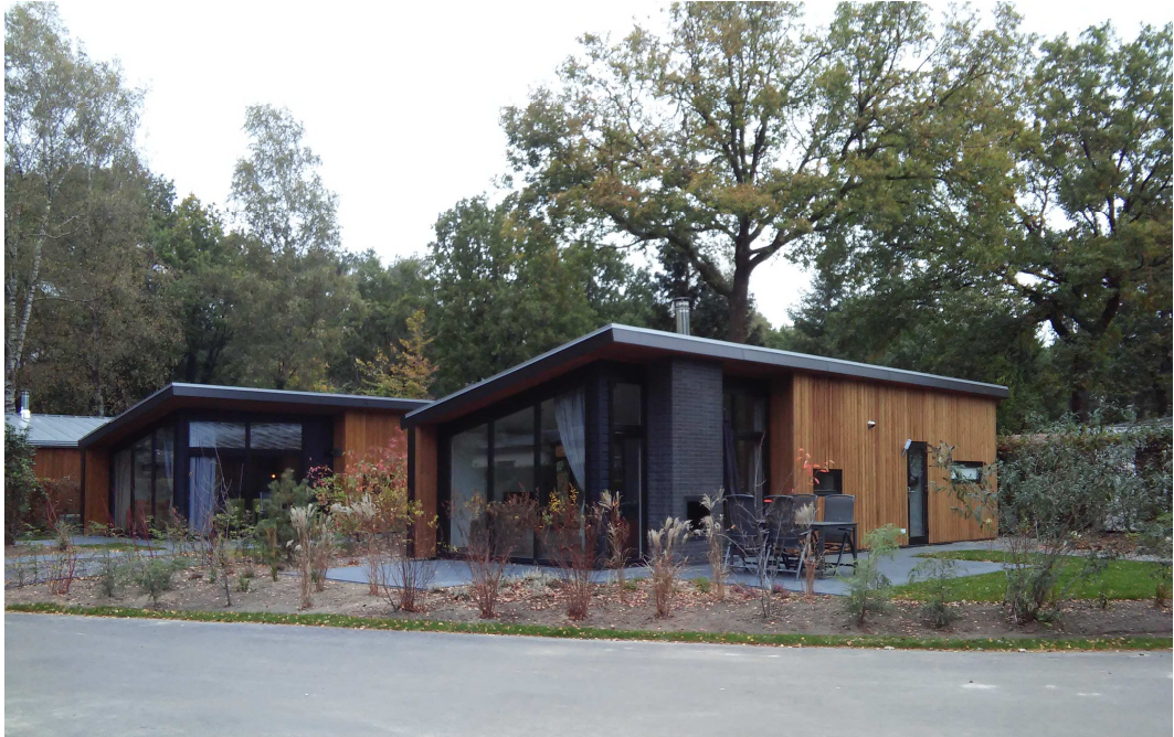
Figuur 21: Recent geplaatste duurzame recreatieverblijven
