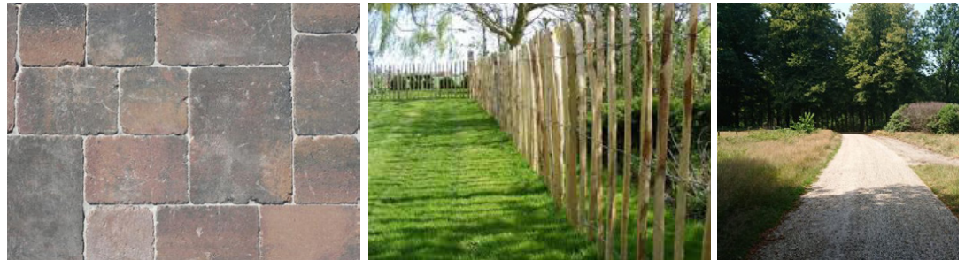
Gebruik van wildverband voor de terrassen dicht bij de gebouwen, toegangsweg naar boskamers is Achterhoeks Padvast verharding.
