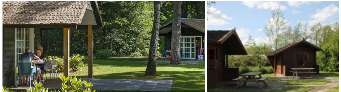
De verblijven in de Boskamers zijn gelijk geschikt aan elkaar. De gebouwen bestaan uit één bouwlaag met kap.
