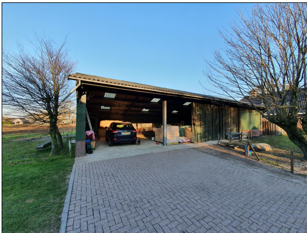
Figuur 2 De te saneren kapschuur op de planlocatie.
