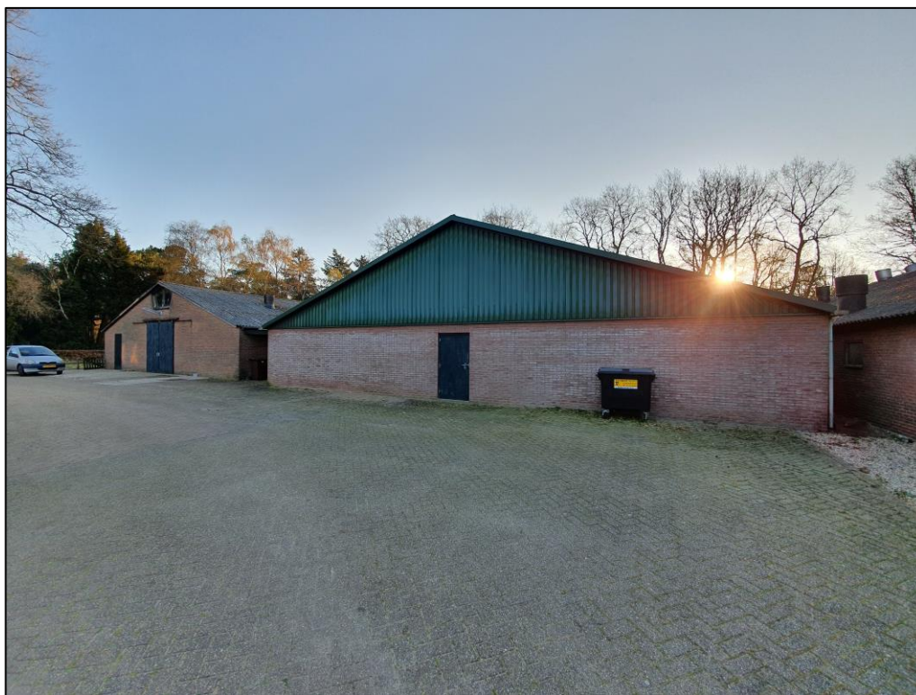
Figuur 1 De beoogde ontwikkelingen bestaan uit het saneren van vier varkensstallen, een kapschuur en een kas.
