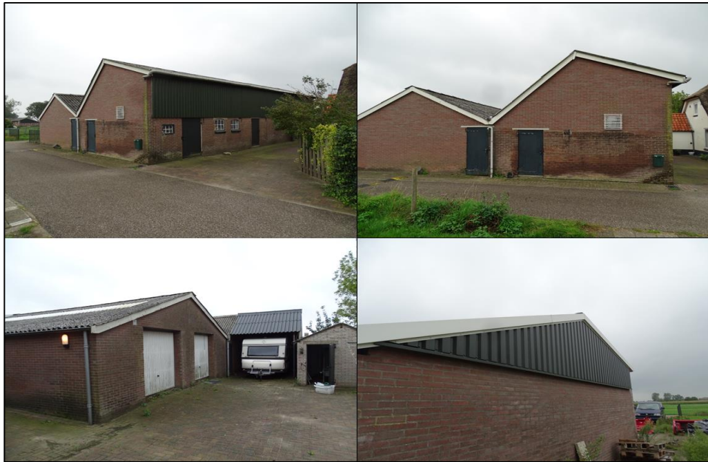
Figuur 3 De te saneren werkschuren. De meest oostelijke schuur (A) is boven afgebeeld en de meest westelijke schuur (B) is onder afgebeeld.
