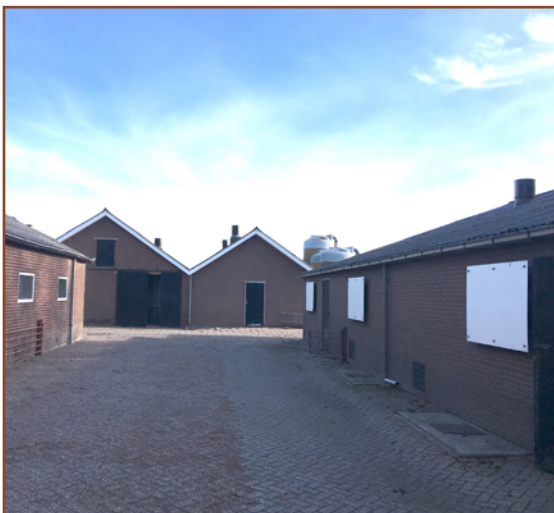
Afb. 2.4: Overzicht van de te slopen varkenstallen op de locatie. De bebouwing is vrij van verrommeling, goed onderhouden en vrij van geschikte toegangen.
