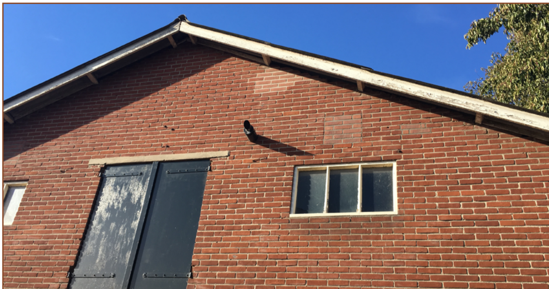
Afb. 2.1: De te slopen varkenstal aan de meest noordelijke zijde van het onderzoeksgebied. Zoals te zien op de afbeelding ontbreken gevelopeningen voor vleermuizen vanaf de buitenkant en zijn voormalige openingen dichtgemetseld. Dakbeschot, spouw of andere geschikte verblijfplaatsen ontbreken..
