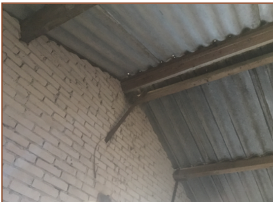
Afb. 2.2: Zoals op deze afbeelding te zien, is er geen isolatie of dakbeschot aanwezig in de meest noordelijke stal. Geschikte verblijfplaatsen voor vleermuizen, Huismus of andere dieren met een beschermde verblijfplaats ontbreken daardoor.
