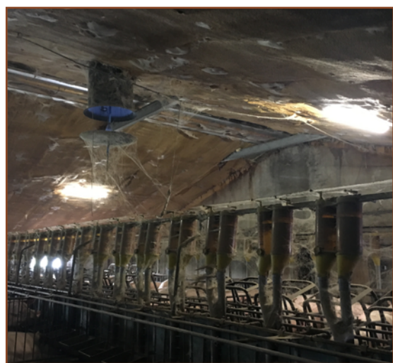
Afb. 2.5: De binnenzijde van de te slopen varkens-/biggenstal. De stal is geheel afgesloten ('geur- en pestdierdicht') en daardoor ontoegankelijk voor vleermuizen, uilen of huismussen.
