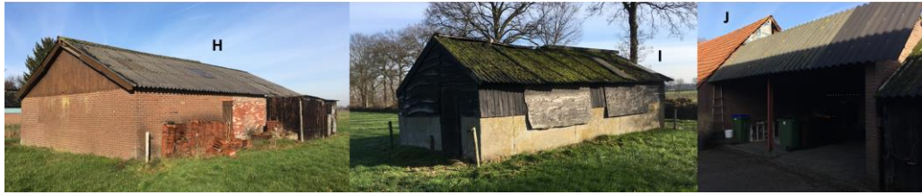
Figuur 3 De bebouwing aanwezig op de planlocatie. Gebouwen A en B blijven behouden terwijl C t/m J worden gesaneerd.
