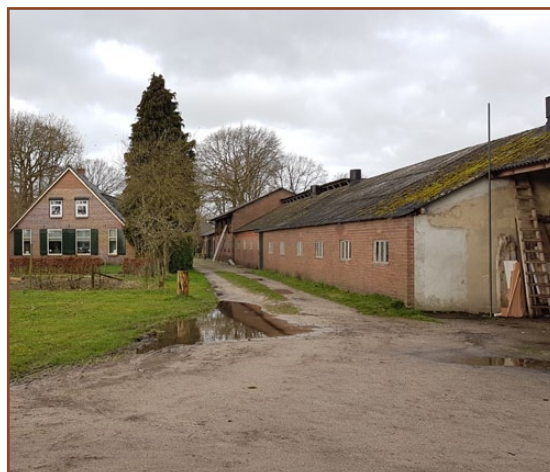
Afb. 2.3: Gedeelte erf in westelijke richting vanaf de oostelijke varkensstal. Links een deel van de woning met coniferen, rechts op de voorgrond te behouden bebouwing met daarachter het te slopen gedeelte.
