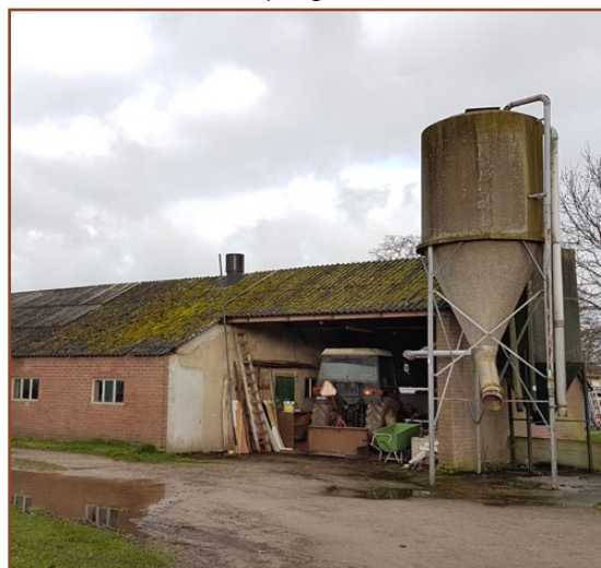
Afb. 2.5: Te behouden kapschuur en eveneens te behouden gedeelte van een voormalige varkensstal.
