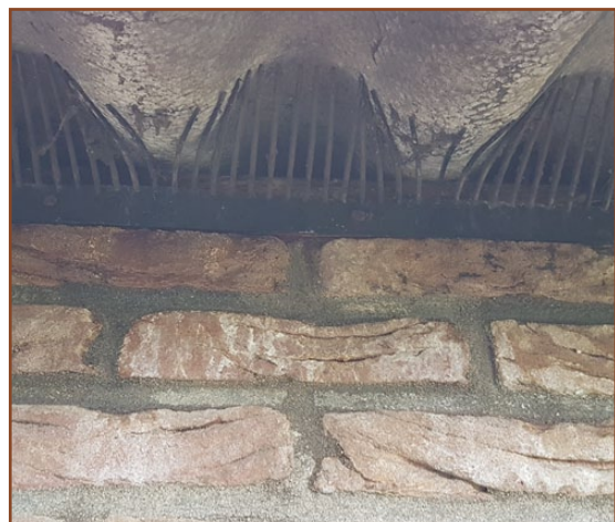
Afb. 2.8: Met vogelschroot dichtgezette dakrand van een stal.
