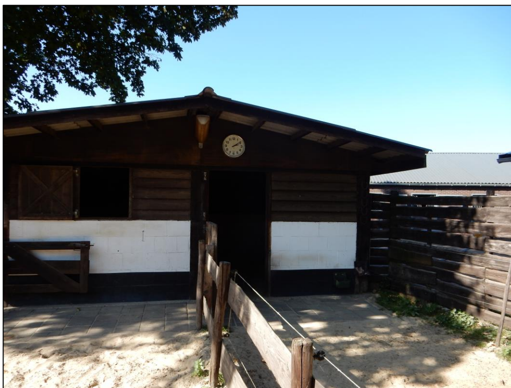
Figuur 3 Het vooraanzicht van schuur B.
