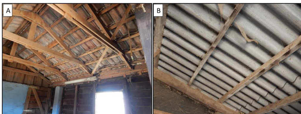
Figuur 5 Visuele representatie van de daken van de te saneren schuren. (A) Het dak van schuur A, bestaande uit dakpannen. (B) Het dak van schuur B, bestaande uit golfplaten.
