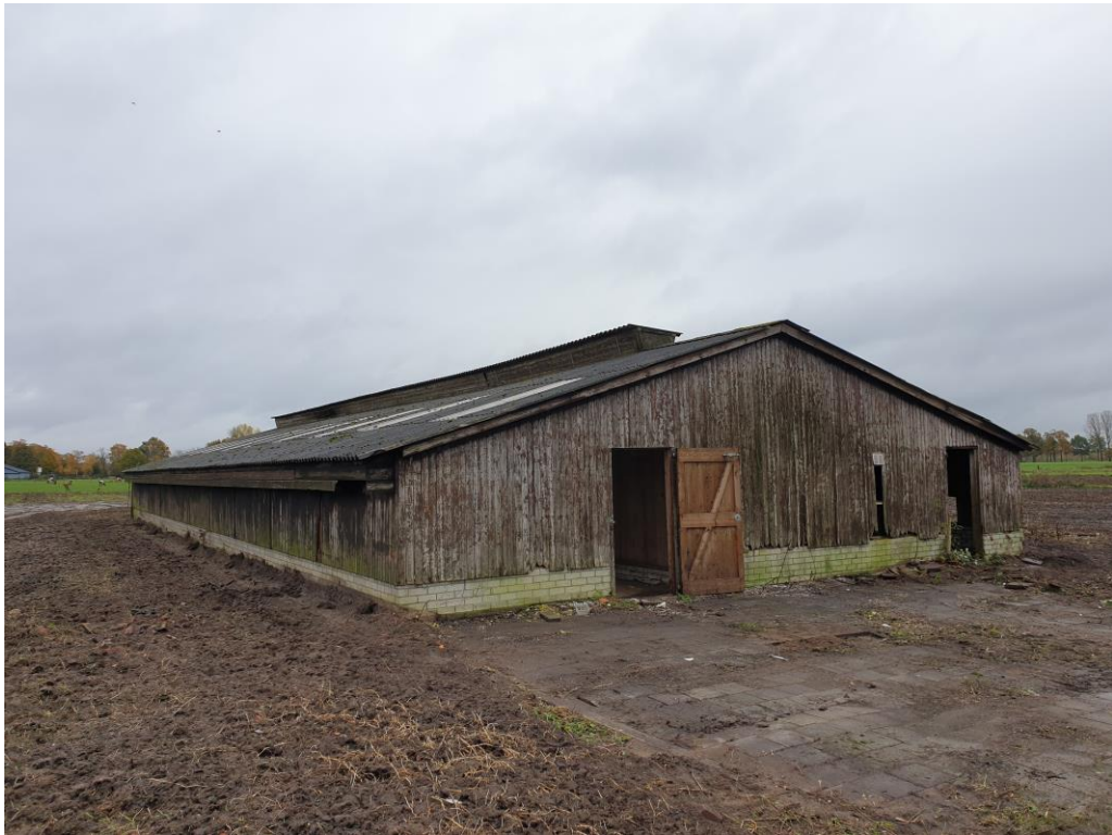
Figuur 1 De te saneren schuur is opgetrokken uit betonnen muren met houten panelen en een zadeldak van golfplaten.
