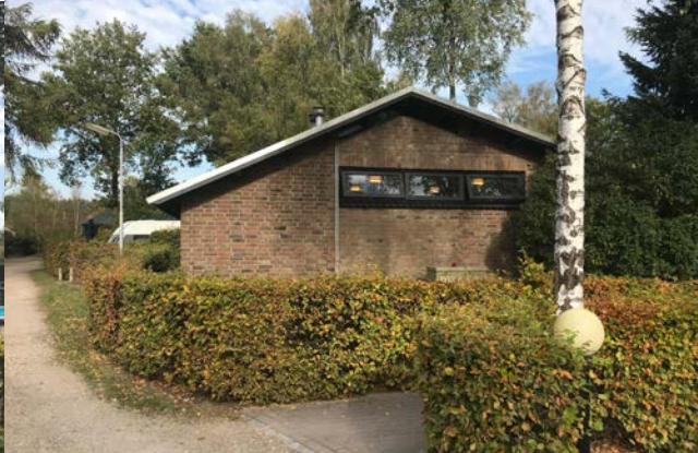
Foto: aankleding rondom toiletgebouw
