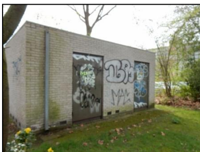
Figuur 6. Elektriciteitshuisje ter hoogte van de nieuwbouwlocatie.
