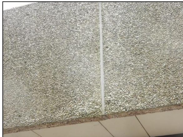
Figuur 11. Tussen de betonnen randen van de laagbouw van het gezondheidscentrum zijn geen spleten aanwezig waar vleermuizen tussen kunnen kruipen.
