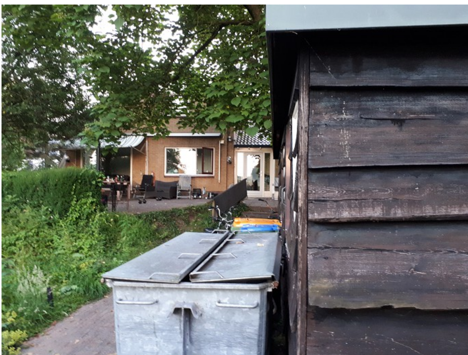
Achterzijde van het plangebied met op de voorgrond de bijbebouwing geschikt voor vleermuizen.
