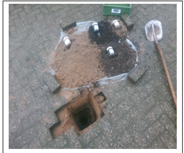
Foto: Inspectiegat A02
