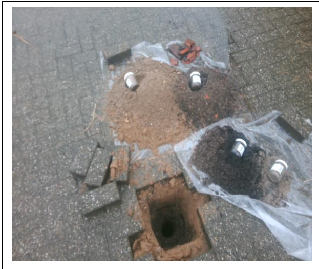
Foto: Inspectiegat A03
