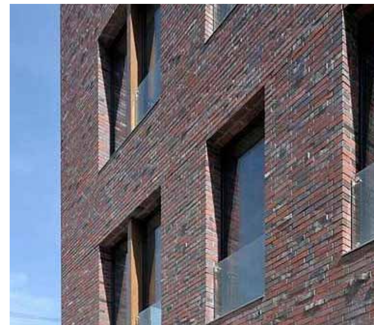
Levendig metselwerk in aardse tinten, voorzien van diepe negges. Metalen en/of houten kozijnen en waterslagen voorzien van grijze en/of naturel kleur.
