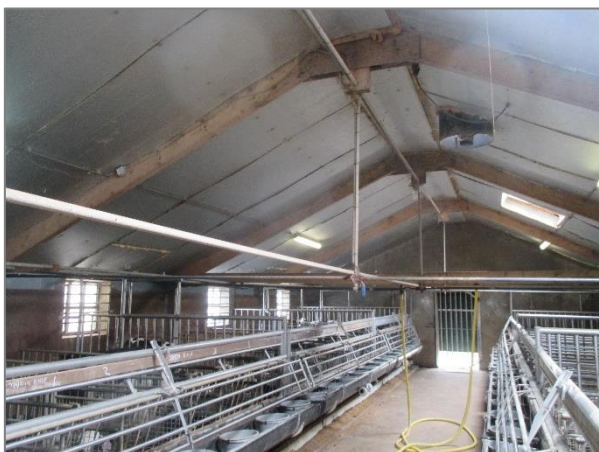
Afbeelding 2.5 | Binnenzijde oostelijke schuur.
