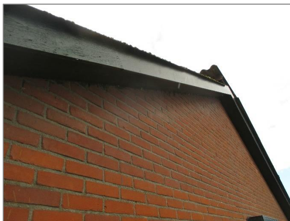
Afbeelding 2.6 | Gevel westelijke schuur.
