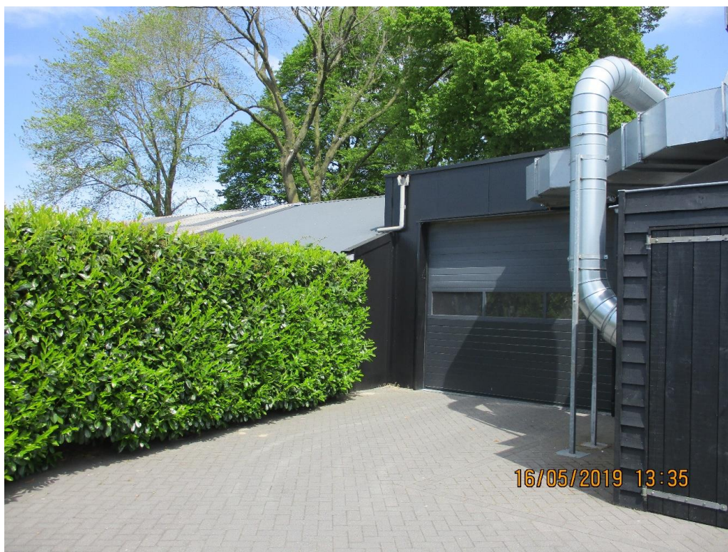
Figuur 2 Te slopen bijgebouw 2 bestaat uit een carport en aanbouw met damwand dak.
