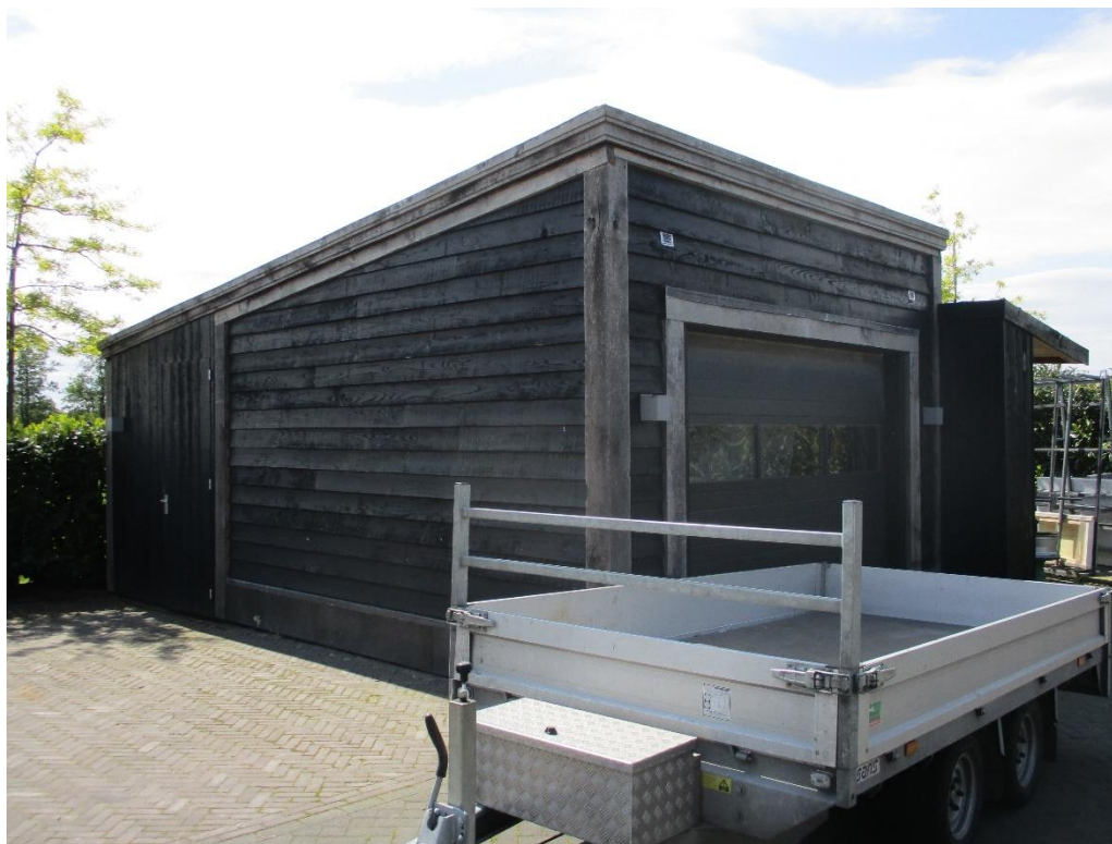
Figuur 1 Te slopen schuur 1 bestaat uit houten wanden en een schuin dak met zonnecollectoren.
