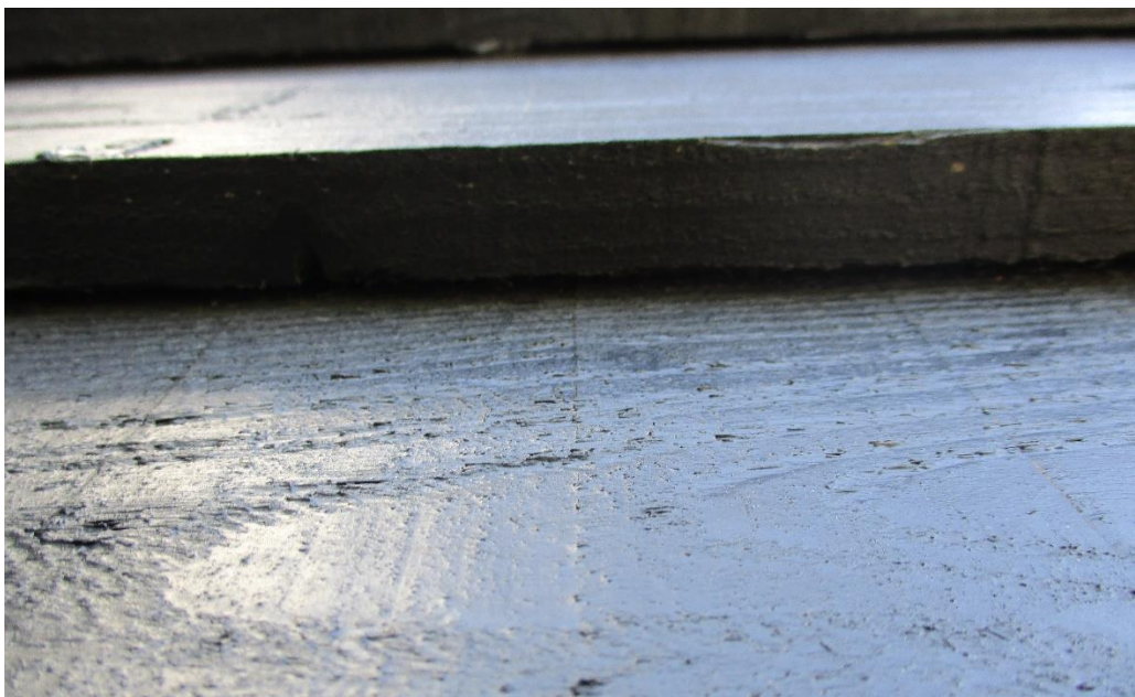
Figuur 4 De planken van de schuren sluiten te nauw aan voor vleermuizen om tussen te kruipen.
