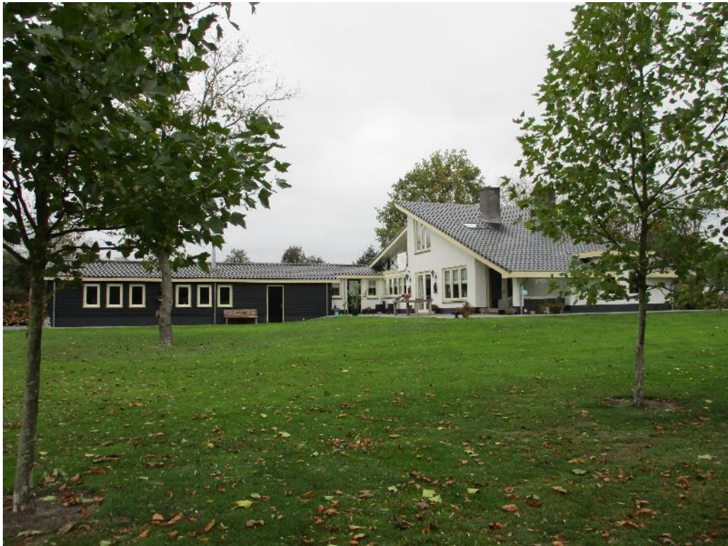
Figuur 1 De planlocatie is gelegen aan de Roekelseweg 22 te Wekerom. Het betreft een woning met aanbouw, een romney loods en voormalige tuinhuis. De woning is opgetrokken uit gemetselde muren met een gladde laag stucwerk en een zadeldak met dakpannen. De aanbouw is opgetrokken uit houten panelen en een zadeldak met dakpannen.
