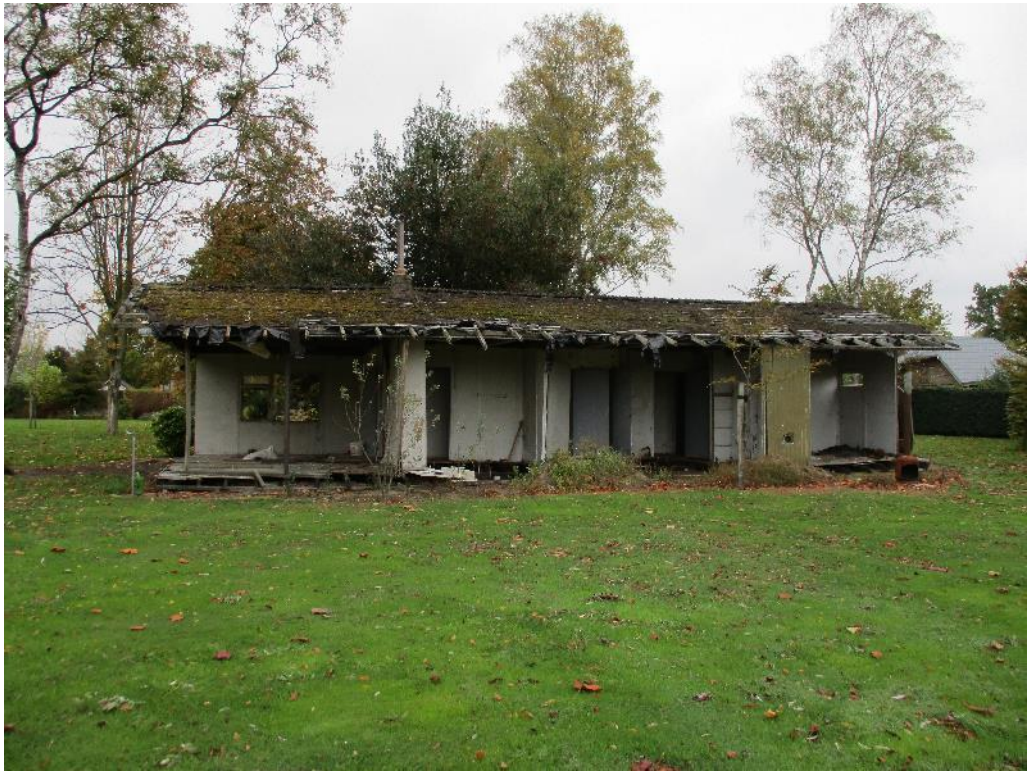
Figuur 3 Het voormalig zomerhuis is deels vervallen waardoor de meeste buitenmuren ontbreken. Het zomerhuis is opgetrokken uit en spaanplaat muren.
