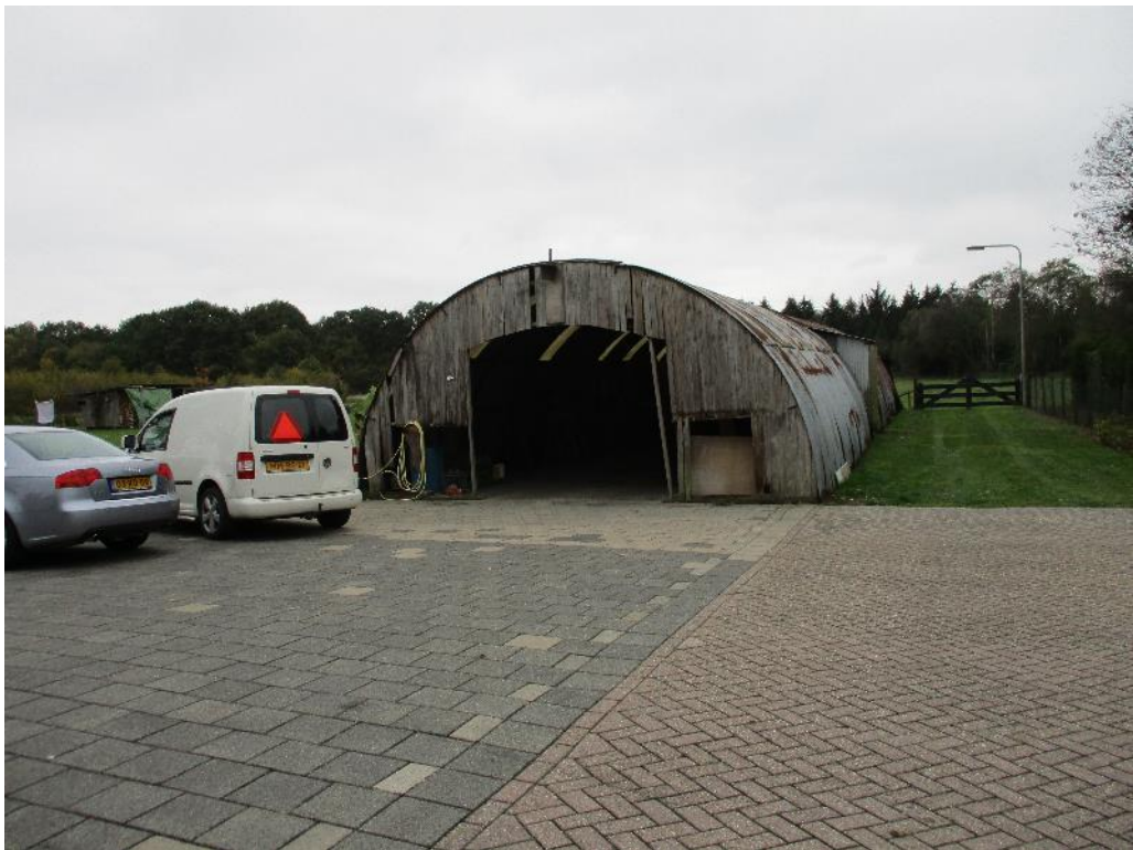
Figuur 2 De romney loods is opgetrokken uit houten panelen en golfplaten en is aan één kant open.
