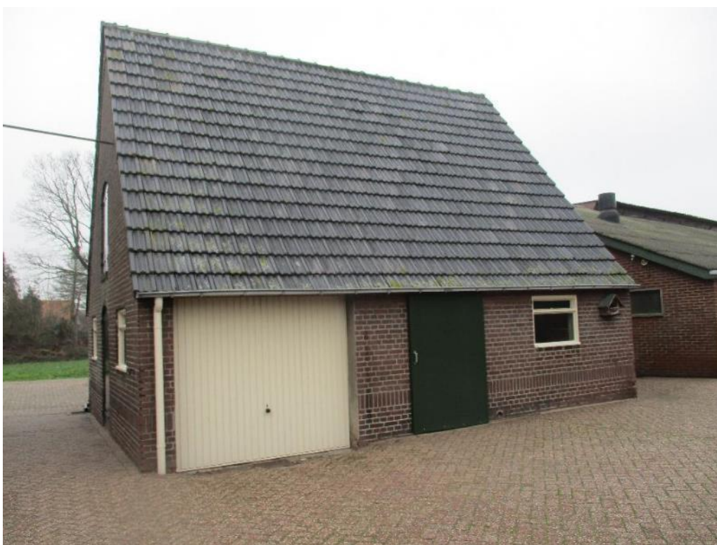
Figuur 2 De schuur met gemetselde muren zonder spouw en zadeldak met dakpannen.
