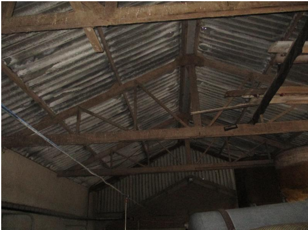
Figuur 6 Overkapping (F). In de overkapping zijn geen uitwerpselen, braakballen of nesten aangetroffen van uilen.
