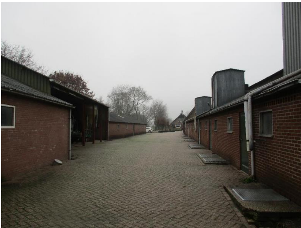
Figuur 1 De planlocatie is gelegen aan de Meikade 6 te Ede en bestaat uit een schuur met gemetselde, muur zonder spouw en zadeldak met dakpannen zonder isolerend dakbeschot en drie stallen met gemetselde muur zonder spouw en golfplaten dak met isolerend materiaal.
