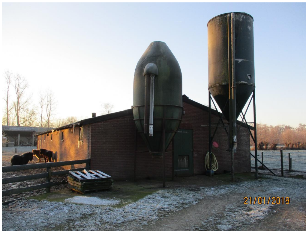
Figuur 1 De planlocatie is gelegen aan de Goorsteeg 10 te Ede. De te slopen stal is opgetrokken uit gemetselde muren zonder spouw en zadeldak met golfplaten.
