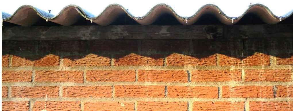
Figuur 2 De dakrand van het golfplaten dak is open, waardoor het dak toegankelijk is voor huismussen
