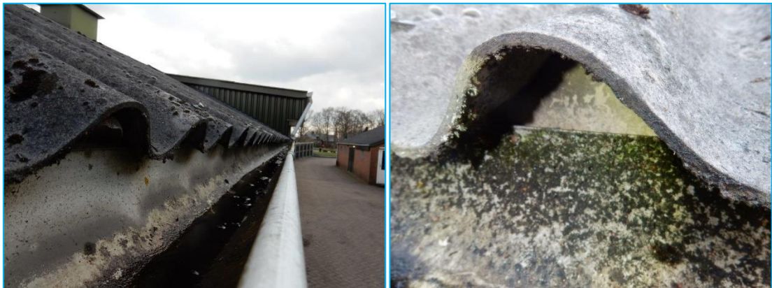
Foto's: Goed te onderzoeken daken en dichtgemaakte openingen.
