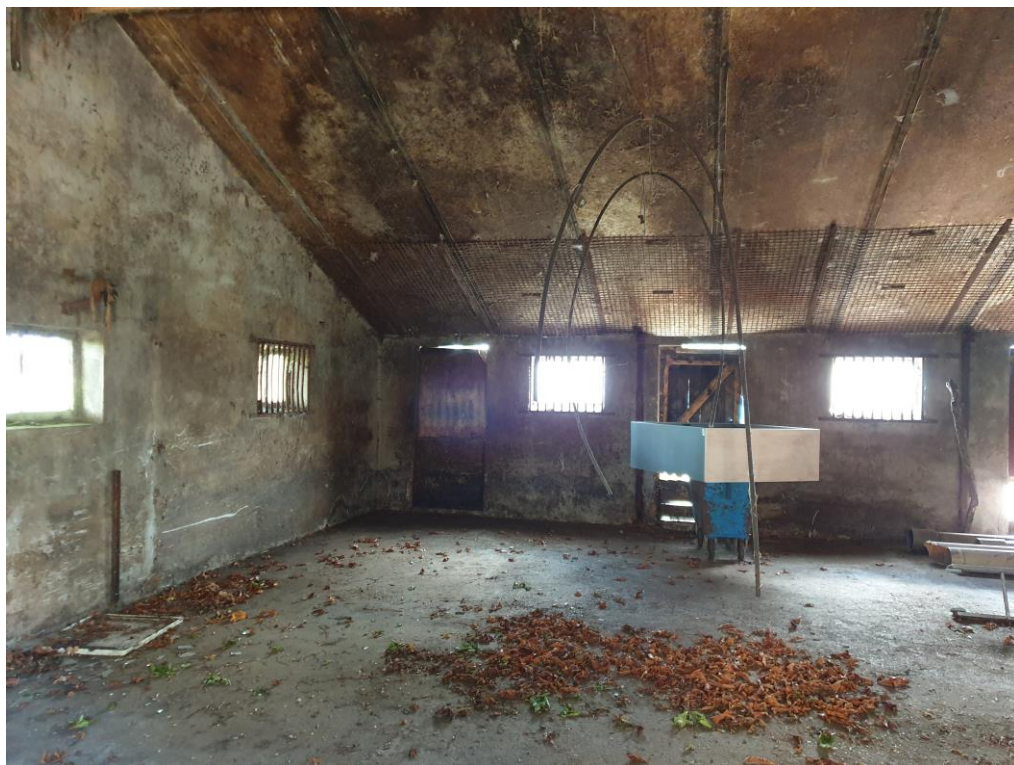
Figuur 2 Schuur B.
