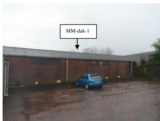
Foto 6: Geïnterviewd bedrijfspan met grootste deel asbesthoudende golfplaat als dakbedekking vanuit noordwestelijke richting gezien.
