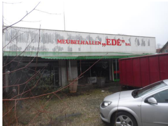
Foto 14: Geïntervieweerd bedrijfspand vanuit noordelijke richting gezien.
