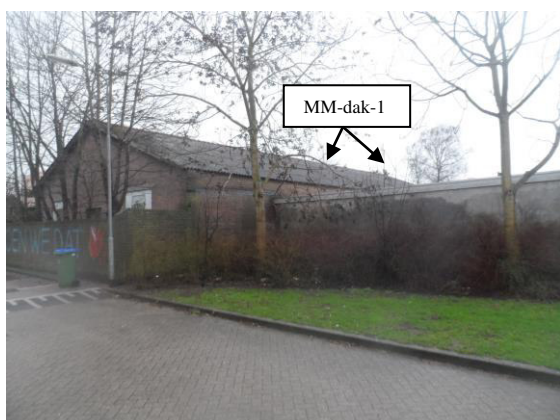
Foto 5: Geïnterviewd bedrijfspan met grootste deel asbesthoudende golfplaat als dakbedekking vanuit noordoostelijke richting gezien.
