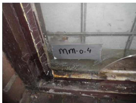
Foto 12: Asbestvrije stopverf in/aan raamkozijnen van bedrijfspand.
