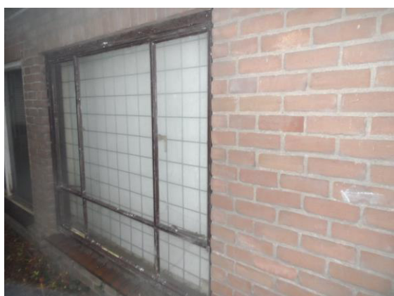
Foto 11: Asbestvrije stopverf in/aan raamkozijnen van bedrijfspand.
