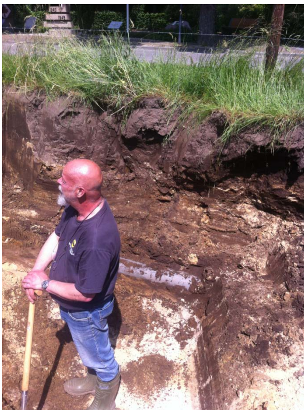
Afb 4: Ontgraving loopgraaf tot aan K&L-tracé
