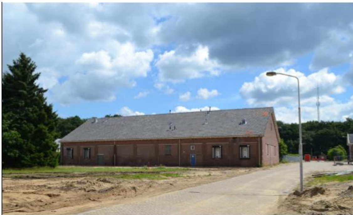
Figuur 4: Uiterlijk gebouw voor transformatie vanuit de westkant bekeken
