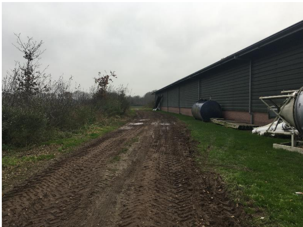
Figuur 4 De achterzijde van de pluimveestallen
