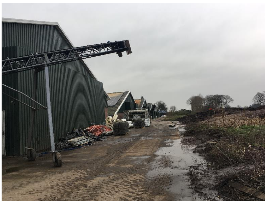
Figuur 2 De oostelijk zijde van de zes pluimveestallen.
