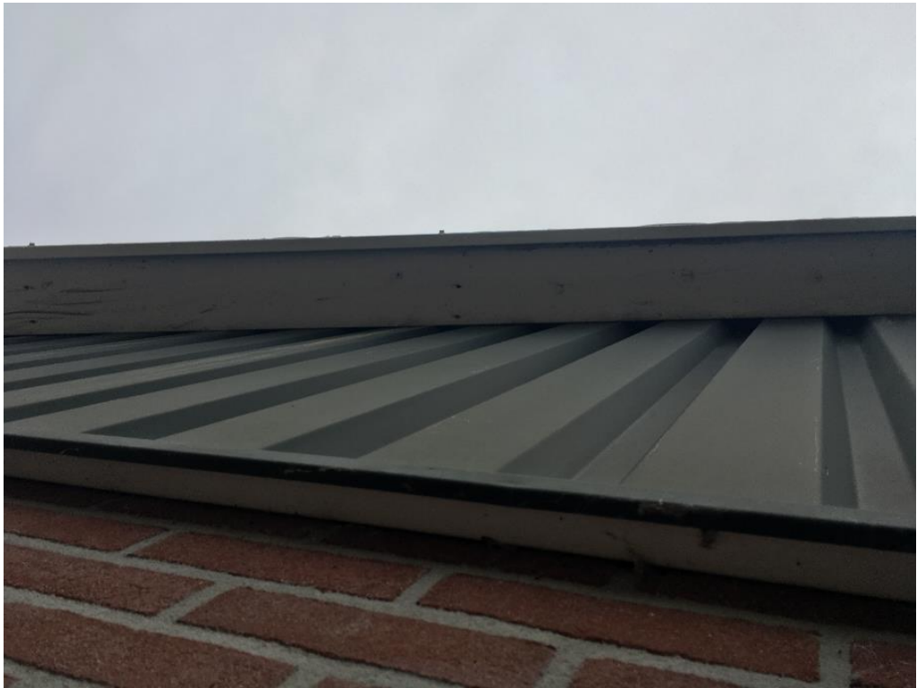
Figuur 5 De damwandplaten en de geïsoleerde steense muren
