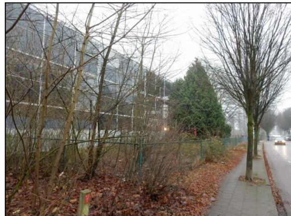
Figuur 12. Coniferen langs de Verlengde Maanderweg. Er zijn geen sporen van gebruik door ransuil of huismus waargenomen.
