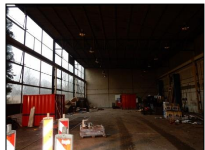
Figuur 8. Binnenzijde resterend deel voormalige werkplaats.
