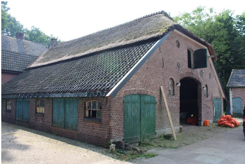
Figuur 14: De deel met in de achtergevel muurankers die het jaartal 1900 vermelden
