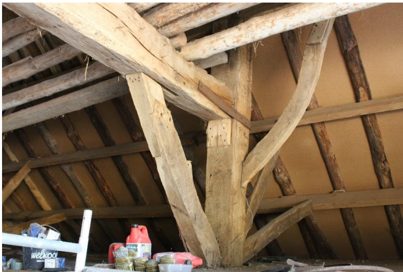
Figuur 15: Gebintenconstructie van de deel
