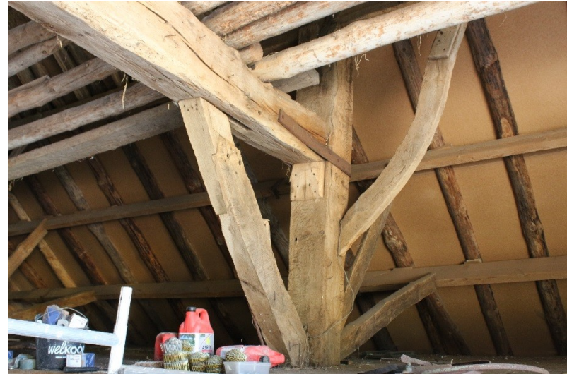
Afb. 7 Gebintenconstructie van de deel
