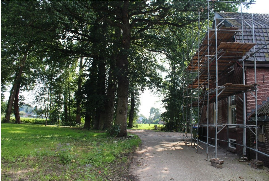
Afb. 4 Langs de zuidzijde van het erf staat een rij oude eiken. Deze groenstructuur loopt in een bocht naar de Tepelenburgweg en markeert daarmee de trechtervormige structuur van het erf
